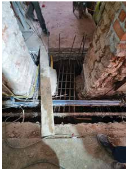
Izvođenje ojačavanja temelja
