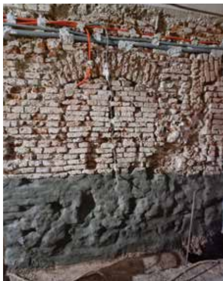
Saniranje kapilarne vlage na zidovima prizemlja
