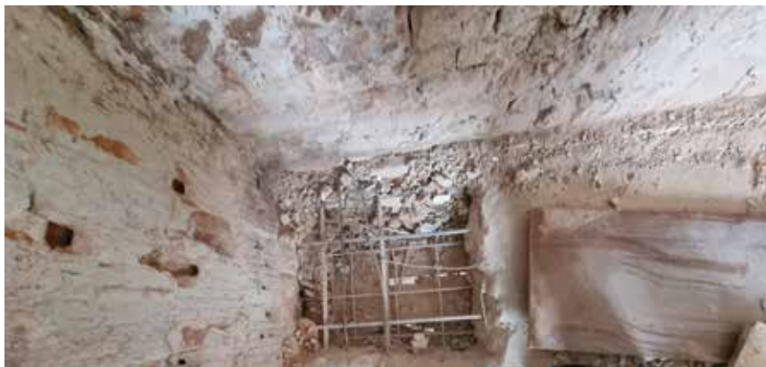
Detalj s gradilišta, pogled na međukatnu konstrukciju s prvog kata
